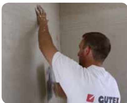
Incorporer le treillis d'armature GUTEX Universal-Armierungsgewebe sur toute la surface
