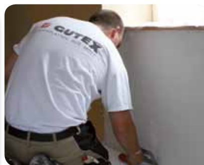
Appliquer l'enduit GUTEX Feinspachtelputz pour créer une surface prête à tapisser
