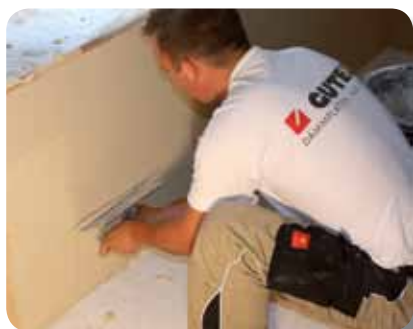
Créer l'enduit de base avec GUTEX Klebe- und Spachtelputz
