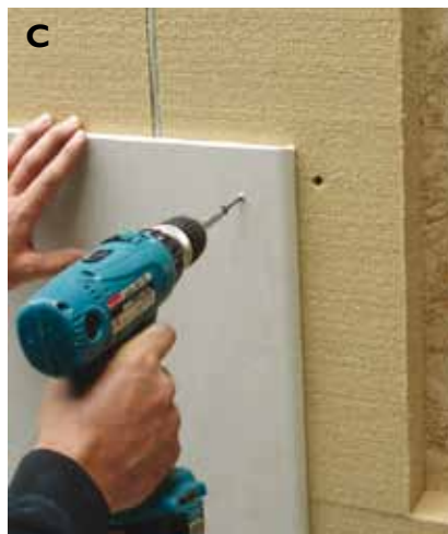
A Fixation de GUTEX Thermoinstal B Fraisage des chemins de câble C Pose du panneau en plâtre
