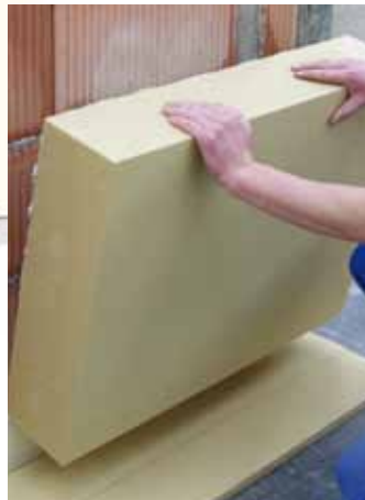
▼ Pose sur maçonnerie
