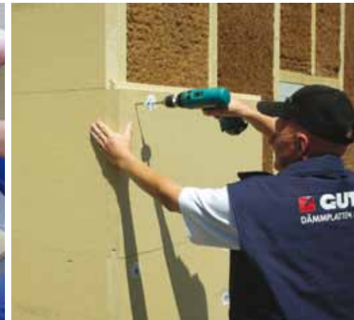
▼ Pose sur montants en bois
